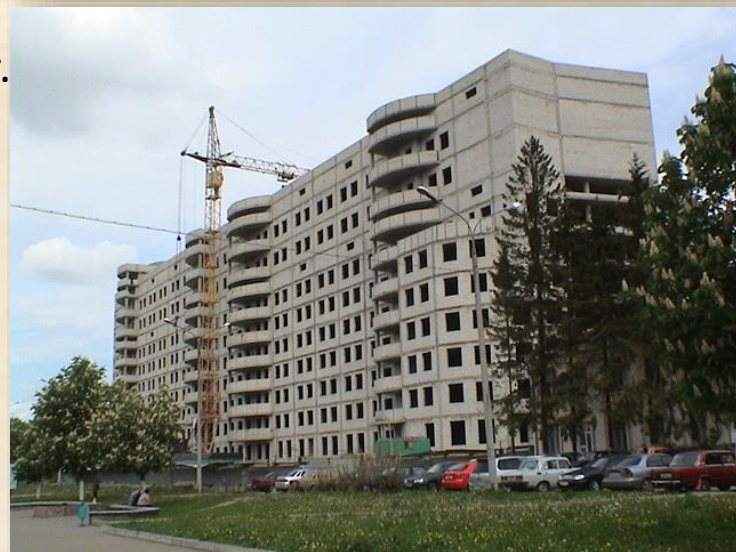
Вид корпуса в настоящее время
